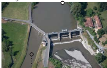
Départ du canal d'aménée
