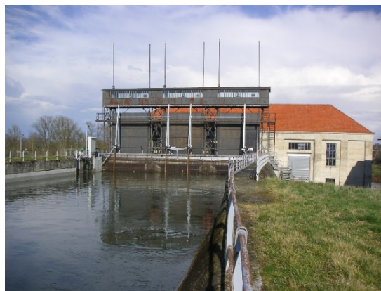
Photo 2 : Canal d'amenée et centrale de Pointis
