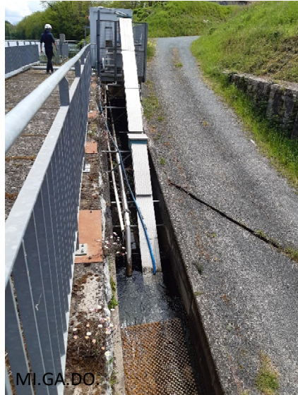
Figure 36 : Passe à anguilles installée sur le site de Tuilières en 2010.
