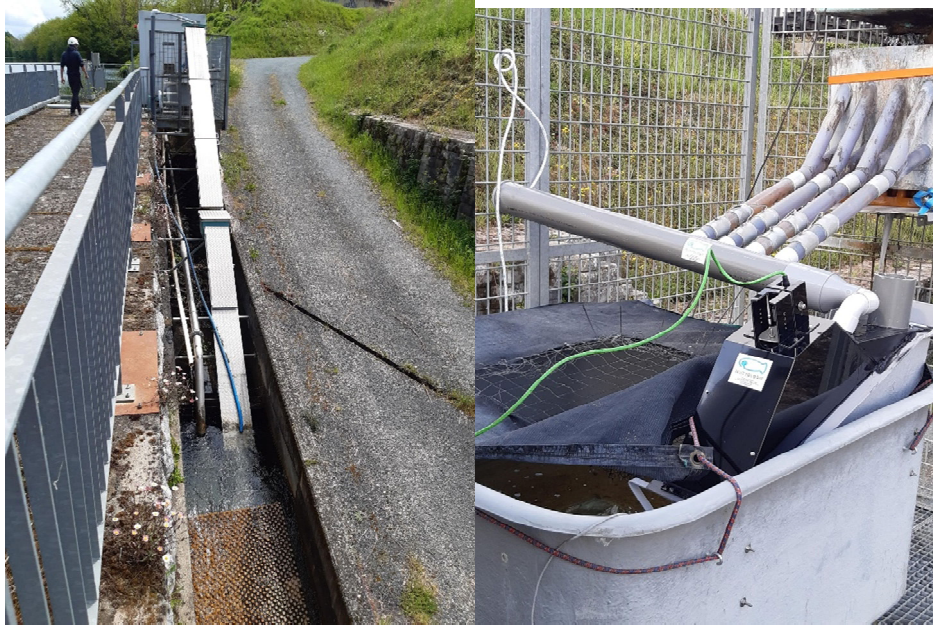
Figure 49 : Système de comptage automatique video installé sur le site de Tuilières en 2021
