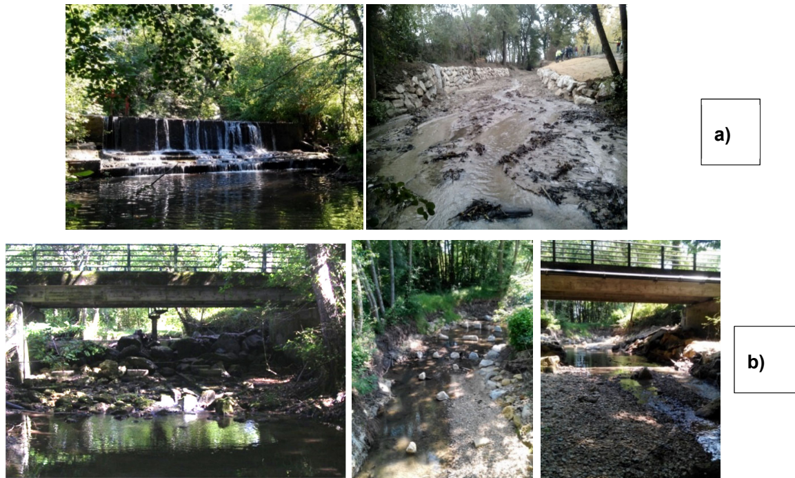
Figure 75 : Arasement de l'ouvrage aval, Moulin du Coutou (a) et démantèlement et réaménagement du seuil de répartition du Pont de Chateau (b)
