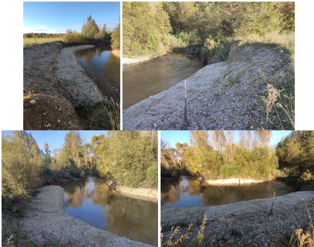
Illustration 31. Travaux du SBGH sur le traitement de l'atterrissement (SBGH ©)
