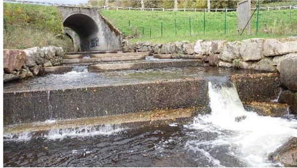
**Figure 25 : La confluence du Foulissard avec la Dordogne pour un faible débit de la Dordogne. A ce débit l'entrée dans le dispositif est problématique avec une hauteur d'eau aval insuffisante.**
