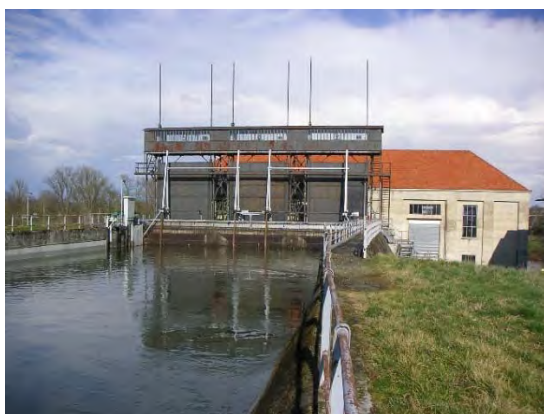
Photo 2 : Canal d'amenée et centrale de Pointis
