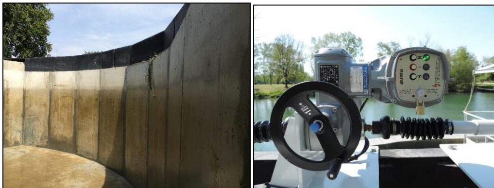
Figure 34 : Illustration du voile béton (gauche) et de la motorisation de la vanne (droite)
