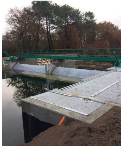
Figure 17 : Photo de la nouvelle écluse (vannes fermées) * au premier plan le coffret béton dans lequel la caméra est installée
