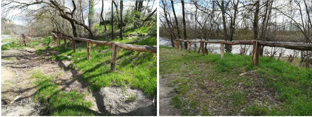
Illustration 14. Mise en place de barrières sur les ramiers de Clermont-le-Fort (MIGADO ©)
