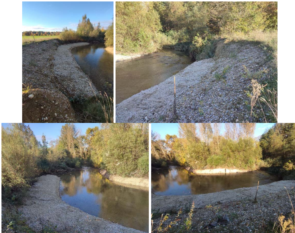
Illustration 36. Travaux du SBGH sur le traitement de l'atterrissement (SBGH ©)
