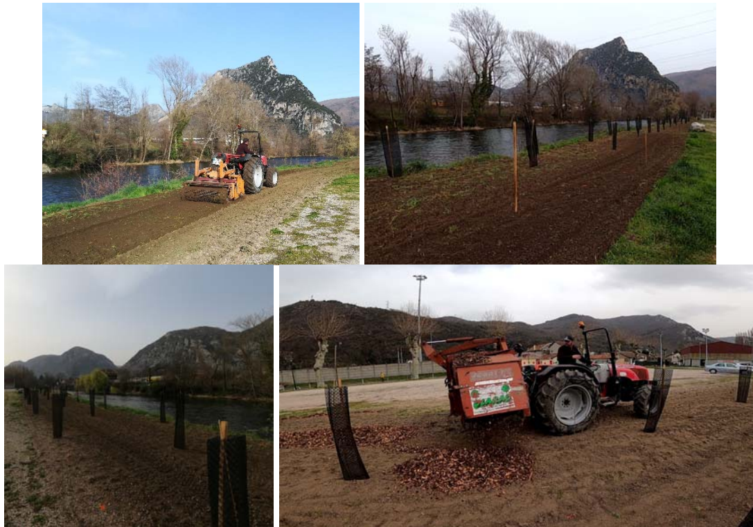
Illustration 7. Travaux de décompactage du sol et de replantation de la ripisylve (MIGADO ©)
