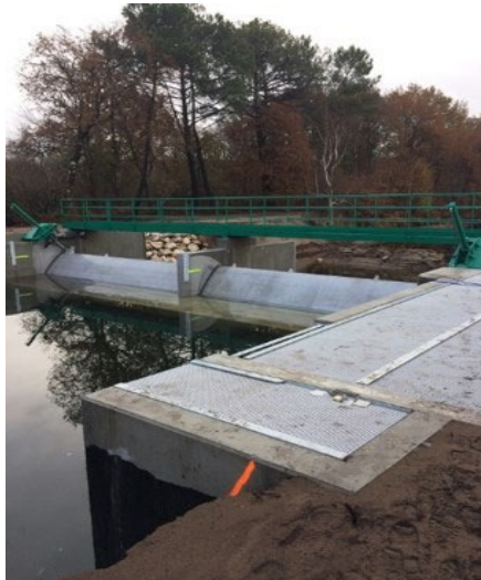
Figure 19 : Photo de la nouvelle écluse (vannes fermées)*
