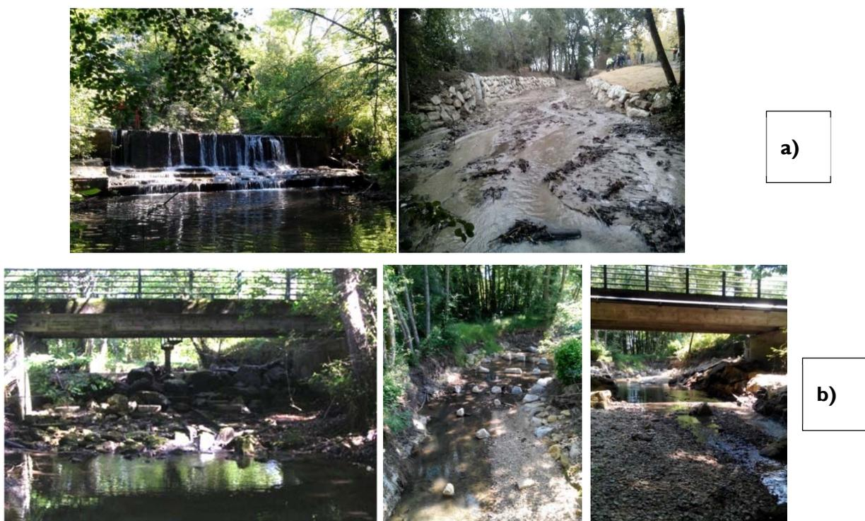
**Figure 63 : Arasement de l'ouvrage aval, Moulin du Coutou (a) et démantèlement et réaménagement du seuil de répartition du Pont de Chadeau (b)**
