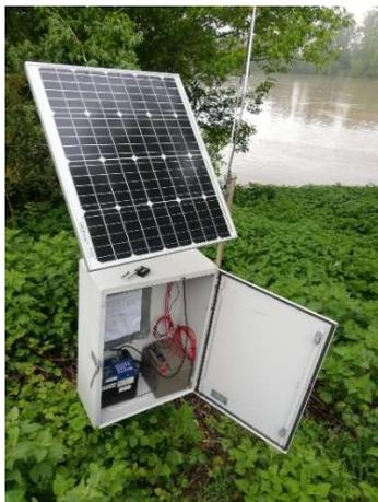
Photo 32 : Installation de station d'enregistrement radio autonome
