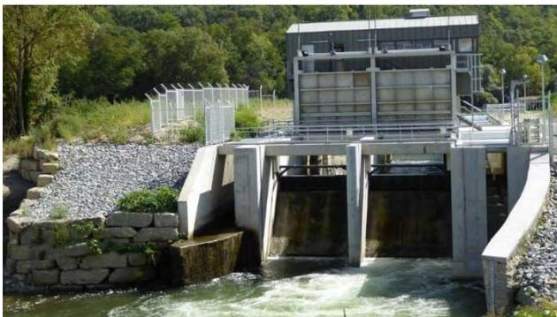
**Photo 18 : Vue aval de l'aménagement de la Cavaletade avec l'entrée de la passe à bassins à droite de la sortie des turbines (source : MJ2 Technologies)**
