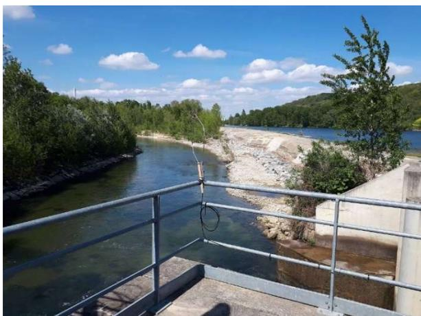
**Photo 35 : Antenne aval (antenne boucle) installée à l'entrée de la passe à poissons de l'usine de la Cavaletade**
