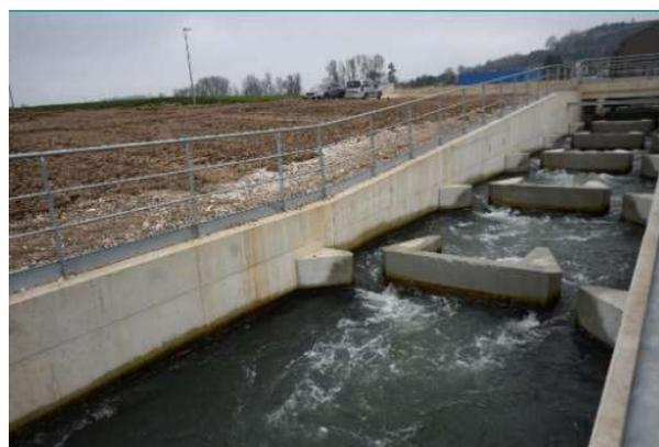
**Photo 12 : Vue de la section en passe à bassins à 2 fentes verticales du dispositif de franchissement de Malause**
