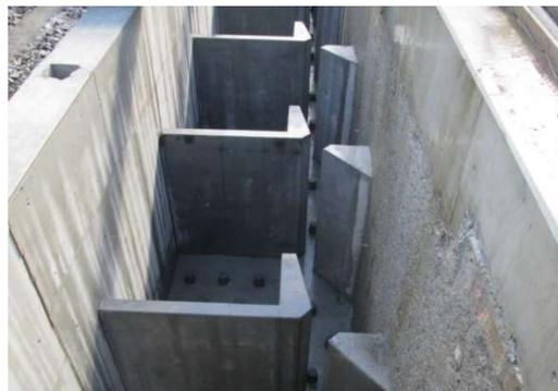
**Photo 19 : Vues des bassins de la passe à poissons avec implantation des rugosités de fond (source : Farcimar)**
