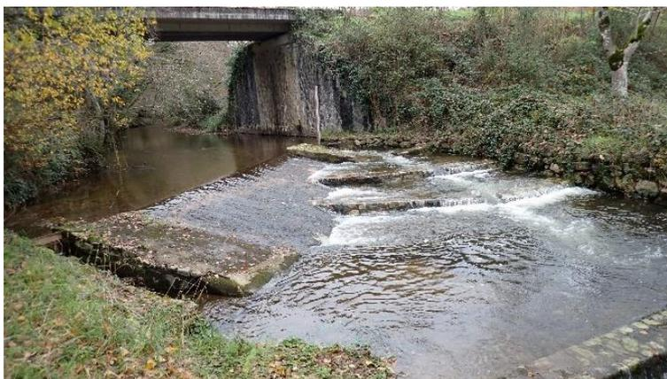
Figure 30 : Passe à poisson du Moulin de Tourte correctement alimentée lors de notre passage.
