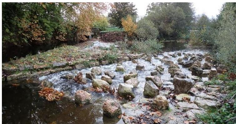
**Figure 32 : Passe à enrochements périodiques du Moulin de la Ségarie correctement alimentée lors de nos passages.**
