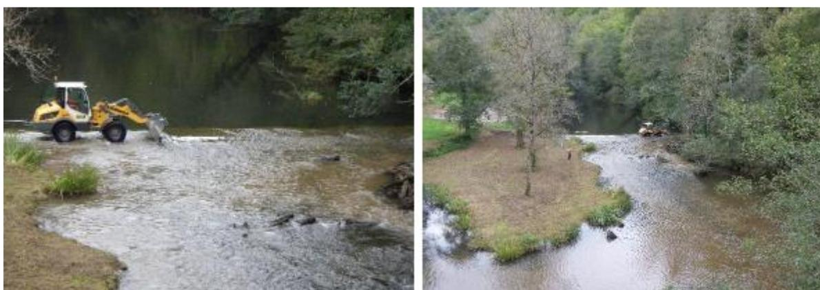
**Figure 21 : Réalisation de l'injection de granulats sur le secteur N (SMDMCA, 2022).**
