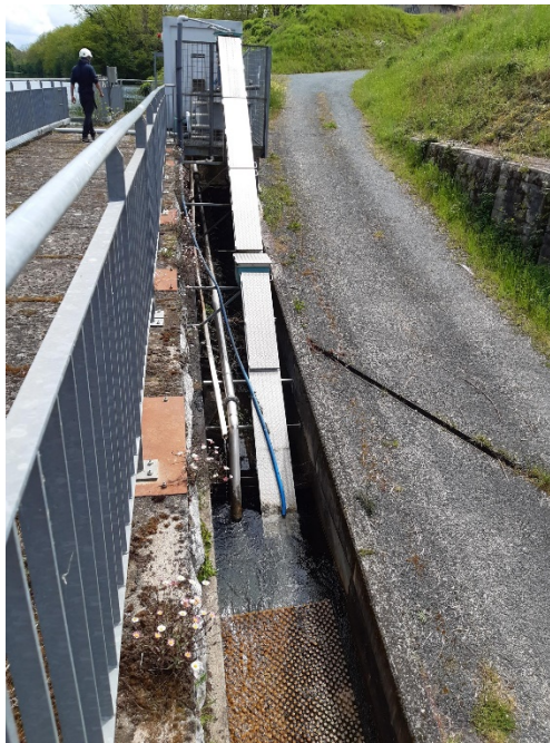
Photo 10 : Système de comptage automatique HIZKIA installé sur le site de Tuilières en 2022
