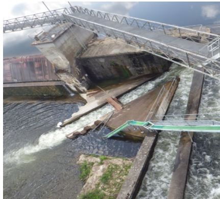
Photo 13 : Passe à ralentisseurs et rampe à anguilles de Mauzac.
