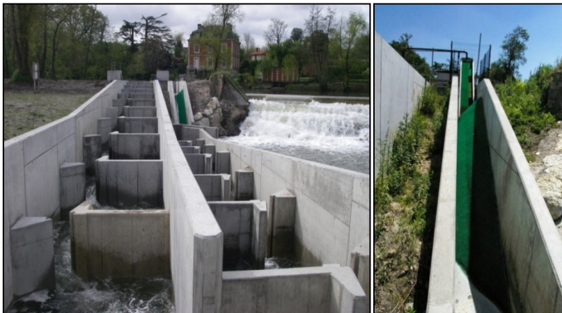
Photo 2 : Passe à bassins et rampe à anguilles de Monfourat.
