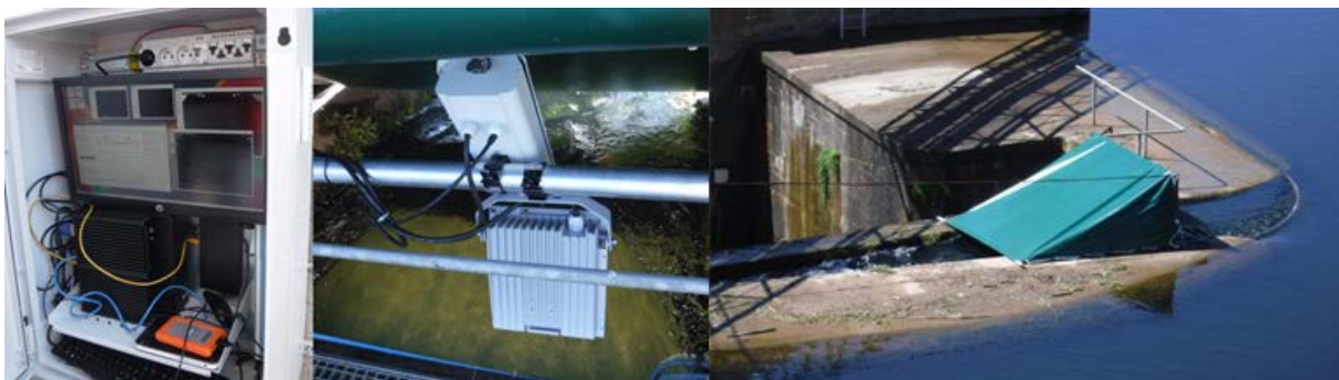
Photo 16 : Le système vidéo de la passe à ralentisseurs du barrage de Mauzac.
