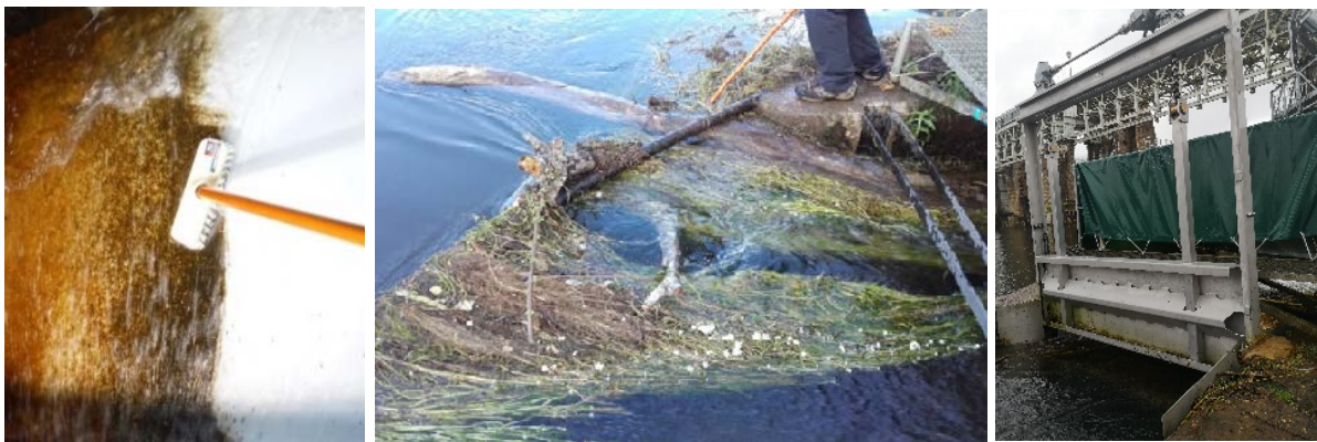
Photo 17 : Nettoyage de la zone filmée, renoncules accumulées dans la drome, vanne à l'amont de la passe à ralentisseurs permettant sa mise hors d'eau.
