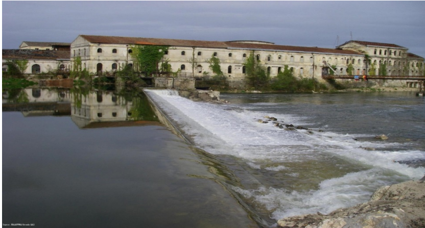
Photo 1 : Le barrage et la centrale hydroélectrique de Monfourat.
