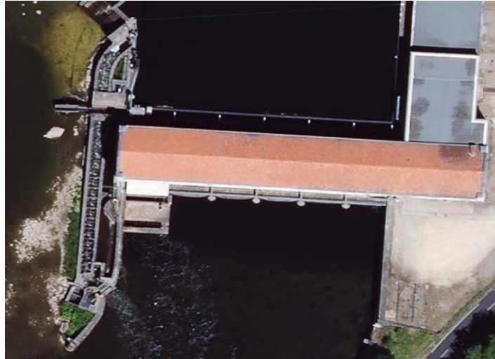
Photo 14 : Passe à poissons de l'usine de Mauzac.
