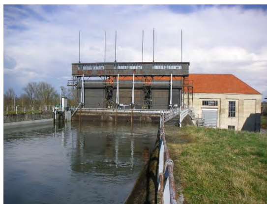
Photo 2 : Canal d'amenée et centrale de Pointis
