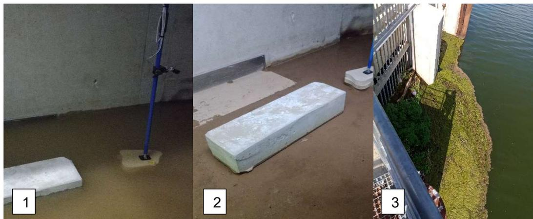
Figure 49 : Photographies illustrant les infiltrations d'eau (1 et 2) dans le local de suivi et le colmatage des grilles amont de la prise d'eau (3) à Malause en 2022
