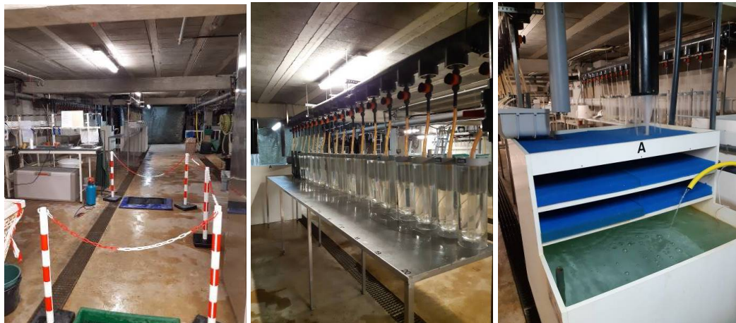
Figure 18 : Installation du matériel dans le laboratoire dédié à la reproduction
