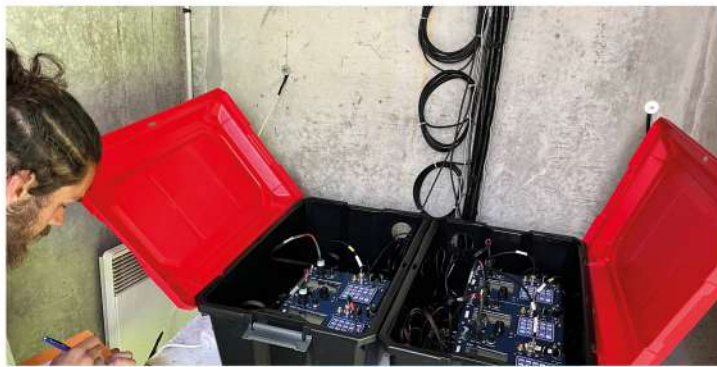
Installation des récepteurs fixes à Crouin
