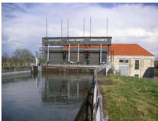
Photo 2 : Canal d'amenée et centrale de Pointis
