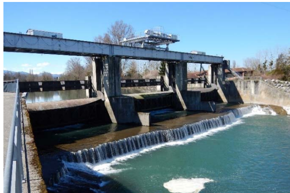
Photo 3 : Barrage de Rodère,
