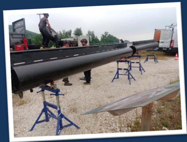
Cette drome, installée en amont de la prise d'eau de la rivière artificielle de Malause, doit permettre d'éviter le colmatage du plan de grille protégeant des corps flottants et ainsi faciliter la délivrance du débit préconisé dans ce système de franchissement
