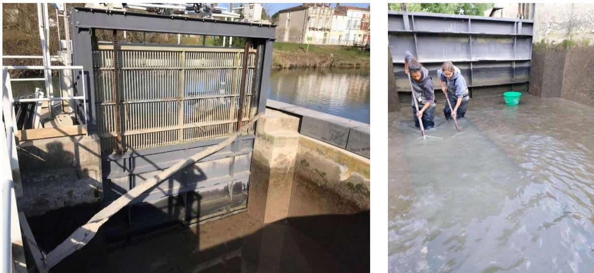
Figure 17 : Zone de piégeage, grille amont et vanne (gauche), fosse de capture (droite).
