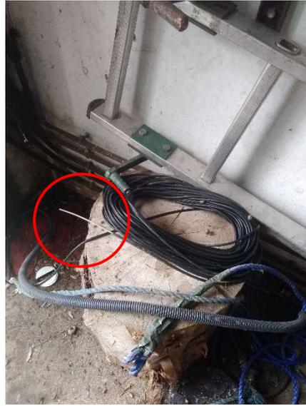
Figure 4 : Câble coaxial dénudé.
