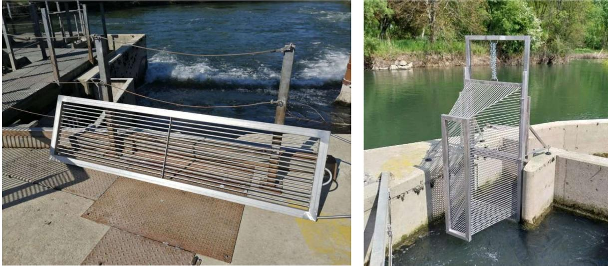
Figure 12 : Grille 1 amont (gauche) et grille 2 aval avec empêche (droite).
