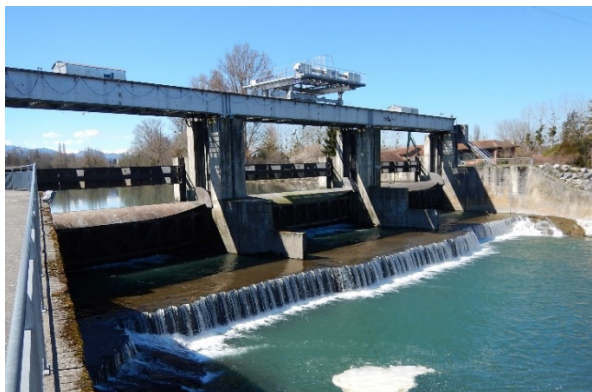
Photo 3 : Barrage de Rodère,
