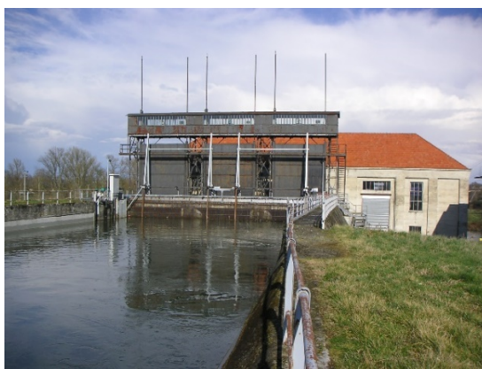
Photo 2 : Canal d'amenée et centrale de Pointis
