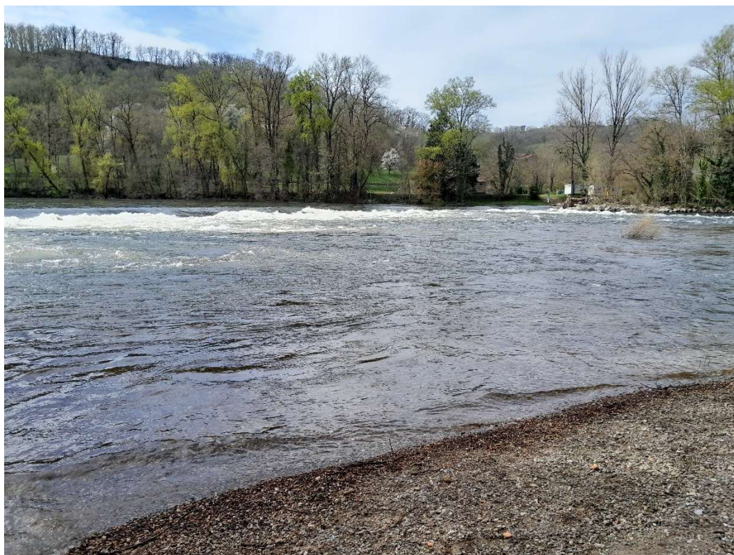
Figure 26 : Vu de l'aval du seuil de Carennac le 25 mars 2024 : débit 257 m 3 /s
