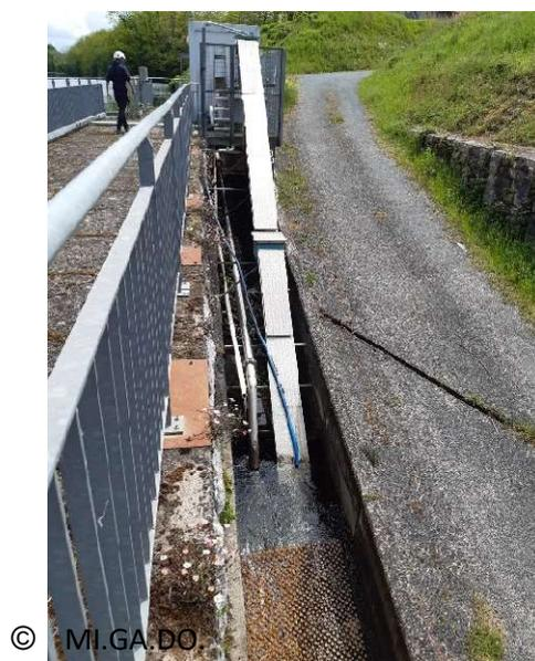
**Figure 31 : Passe à anguilles installée sur le site de Tuilières en 2010.**
