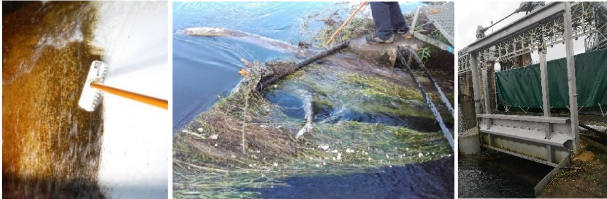
Photo 18 : Nettoyage de la zone filmée, renoncules accumulées dans la drome, vanne à l'amont de la passe à ralentisseurs permettant sa mise hors d'eau
