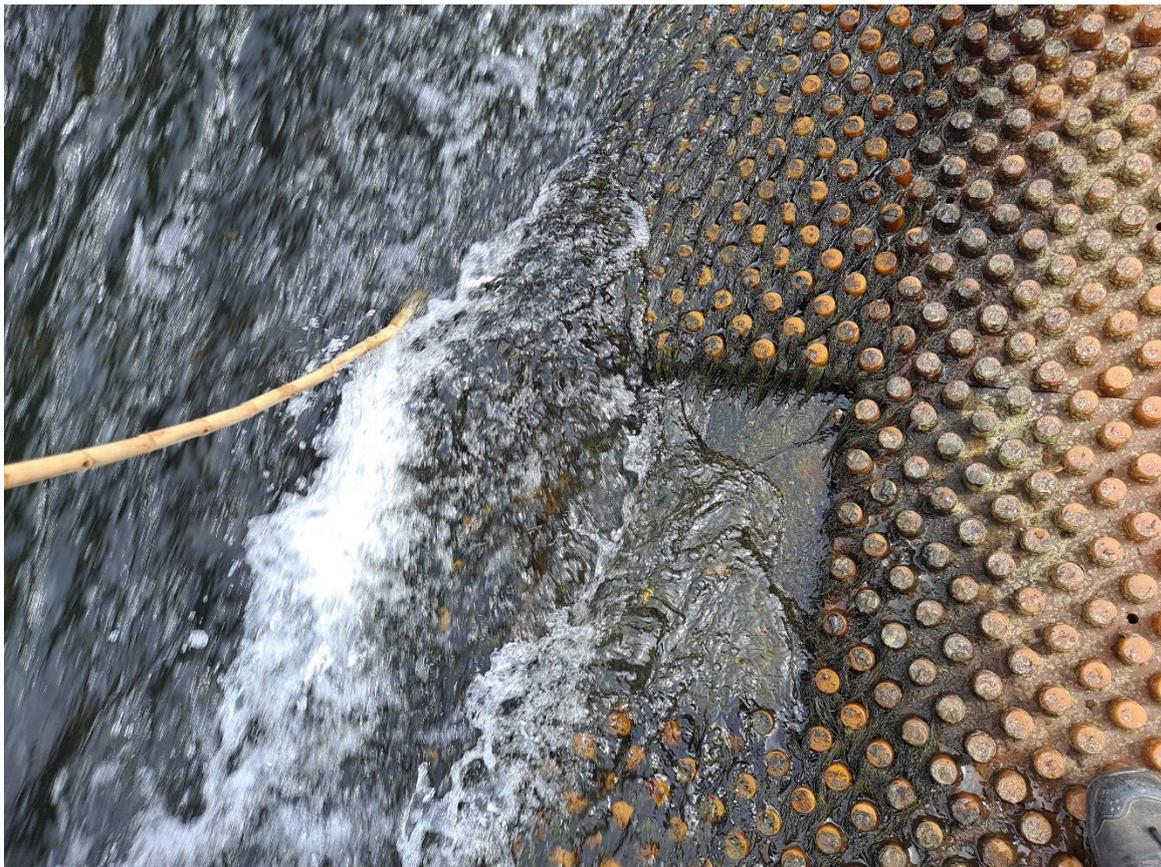
Figure 12 : élément manquant de la passe à anguille de Bergerac le 13/06/24
