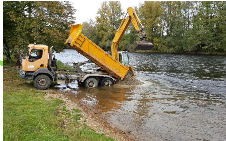
Apport de graviers-galets (ou régalinge et scarification)
