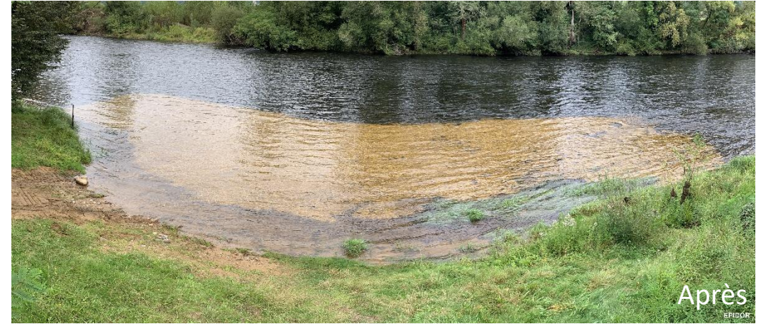
Apport de graviers-galets (ou régalinge et scarification)
