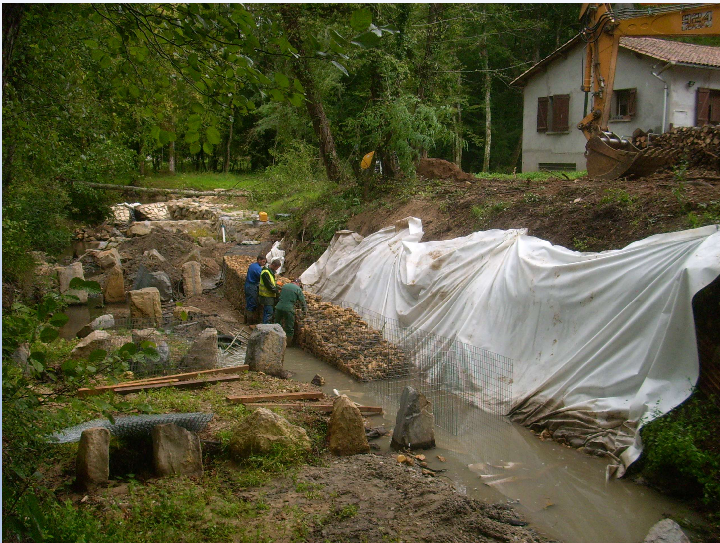
Reprise des travaux en sept 2015
