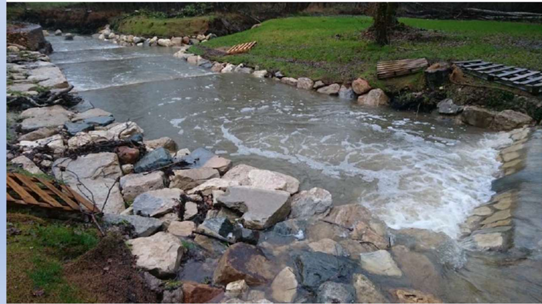
Ouvrage de répartition Eyraud / Barailler – Janvier 2016
