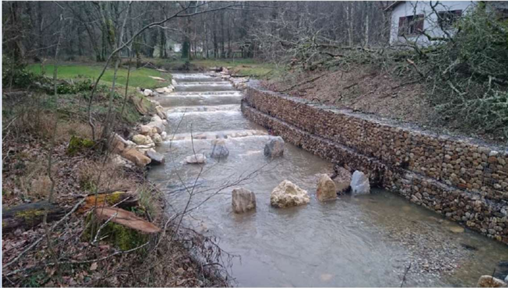
Seuils de Chadeau et protection en rive gauche – photo janvier 2016 post crue
