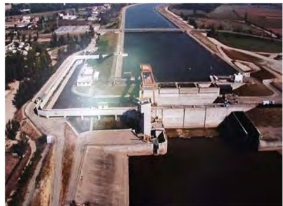
Photo 2 : Vue aérienne du barrage-usine de Golfech et du canal d'amenée (source : EDF)
