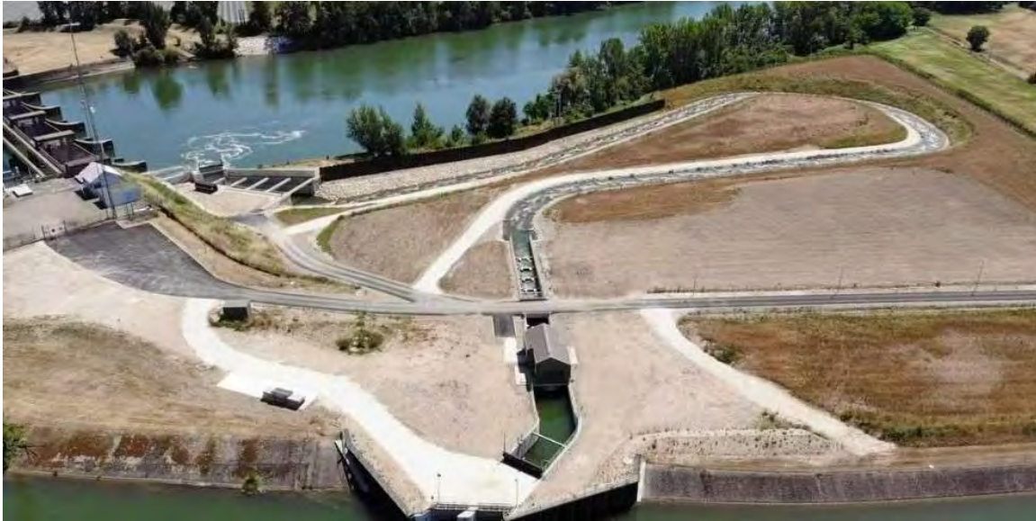
Figure 4 : Dispositif de franchissement mis en place au barrage de Malause (source : EDF)
