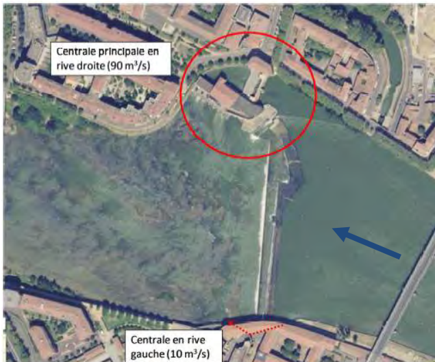
Photo 3 : Vue aérienne du barrage du Bazacle au cœur de Toulouse (source : Géoportail)
