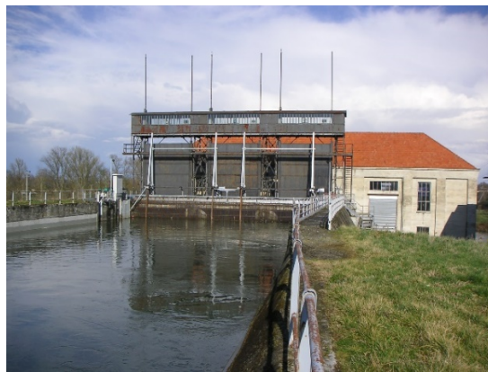
Photo 2 : Canal d'amenée et centrale de Pointis
