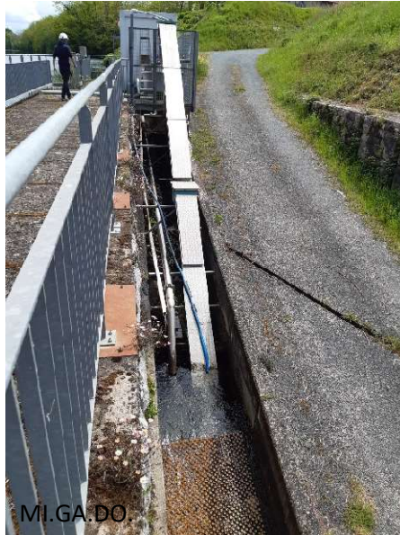
Figure 41 : Passe à anguilles installée sur le site de Tuilières en 2010.
