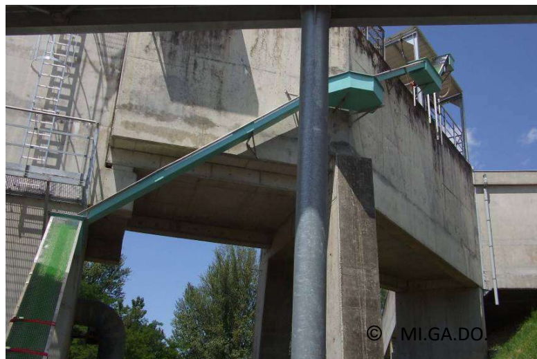
Figure 42 : Passe à anguilles de Golfech.
