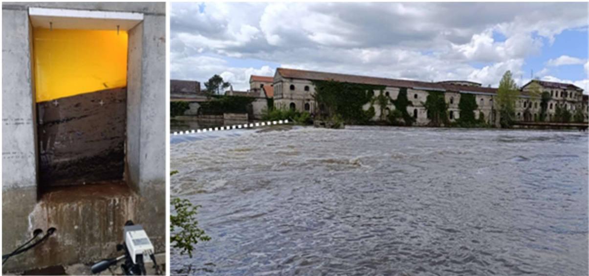
Figure 1 Ensablement de la passe à bassin et surversement du seuil de l'usine
