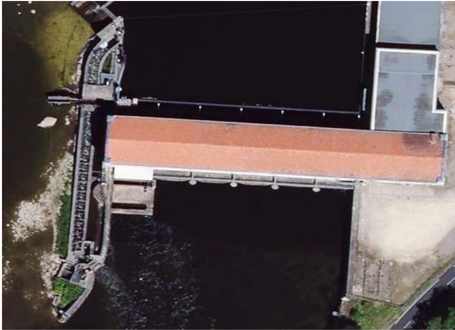
Photo 16 : Passe à poissons de l'usine de Mauzac
