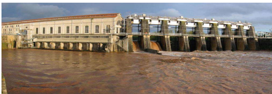
Photo 4 : Barrage de Tuilières vu de l'aval
