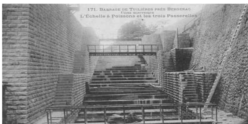
Photo 5 : La passe à bassins originelle de Tuilières en rive gauche
