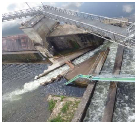
Photo 15 : Passe à ralentisseurs et rampe à anguilles de Mauzac
