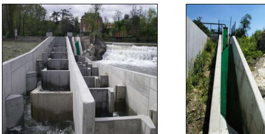
Photo 2 : Passe à bassins et rampe à anguilles de Monfourat
