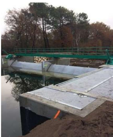
**Figure 13 : Photo de la nouvelle écluse (vannes fermées), au premier plan le coffret béton dans lequel la caméra est installée**
